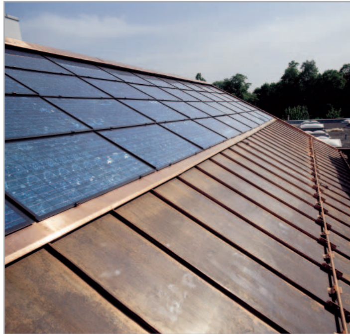
Umweltinvestitionen: In den letzten Jahren wurden im HiPP-Werk Pfaffenhofen weitreichende Umweltmaßnahmen umgesetzt: Insgesamt 432 m 2 Kollektorenfläche und Vollwärmeschutz für die Produktions- und Verwaltungsgebäude haben Emissionen und Energiebedarf stark nach unten geschraubt.
