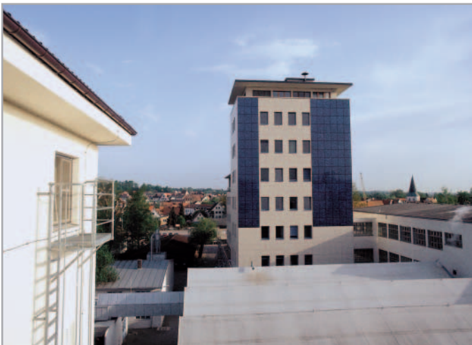
Eine Photovoltaik-Fassade auf dem Turm des Verwaltungsgebäudes liefert auf 154 Quadratmeter Kollektorenfläche Strom und ist ein weithin sichtbares Zeichen für das ökologische Engagement bei HiPP.
