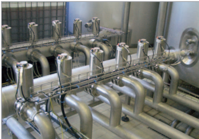
Automatische Absperrventile der neuen vollautomatischen Reinigungsanlage in Pfaffenhofen.
